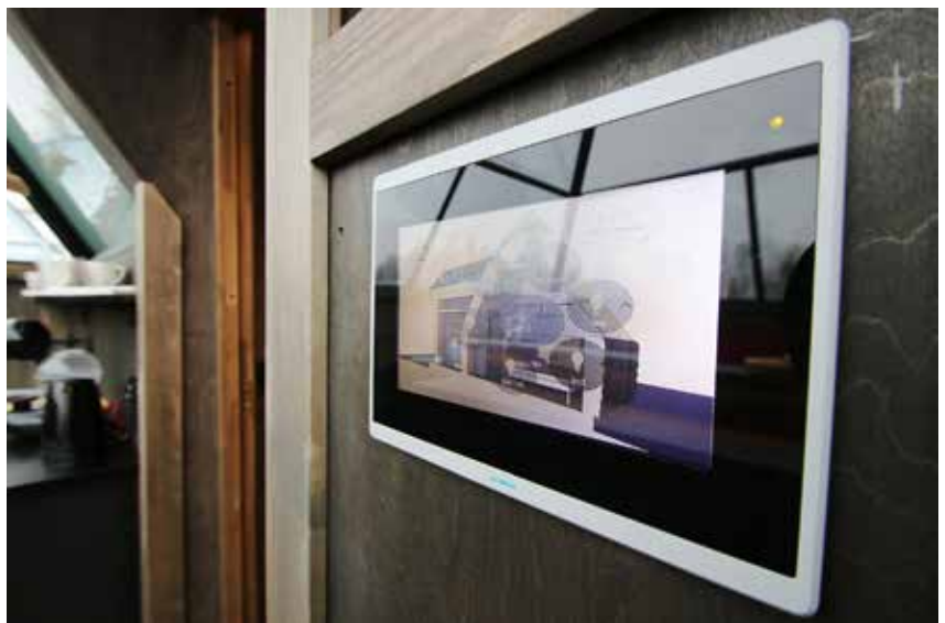
Aurora Pyramidit on kytketty Siemensin virtuaaliseen alustaan ja kiinteistöautomaatioon.
