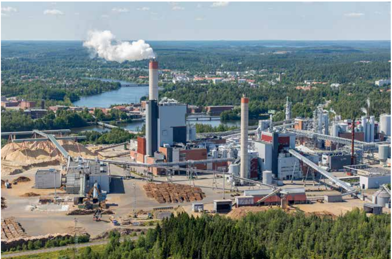
Kymin Voiman biovoimalaitos Kouvolassa. Palamisen optimoinnin ansiosta Kymin Voiman ei tarvitse investoida ammoniakinsyöttöjärjestelmään. Toimitusjohtaja Antti Rainion mukaan päästöt pystytään pitämään raja-arvoissa nykytekniikalla, tarkemmilla säädöillä sekä vähentämällä tyypillisiä polttoaineita.
