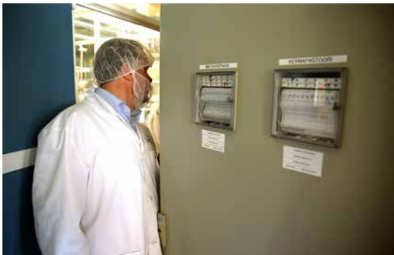
Pian HAM:n opetusmeijerissä ei ole enää käyttöä piirtureille, kun tiedot siirtyvät automaatiojärjestelmästä automaattisesti MindSpheren raportointityökaluun. Sähkökaappiin kurkistamassa Petri Auramo Siemensiltä.
