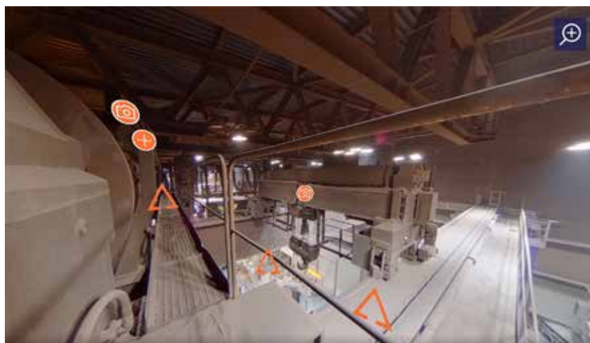
360-työkalulla saadaan merkittävää hyötyä etenkin tarjous-, tilaus- ja asennussuunnittelussa.
