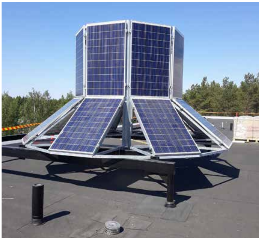
Oulun ammattikorkeakoulun sähkötekniikan opetusympäristössä tutkitaan erilaisia aurinko-energiajärjestelmiä.
