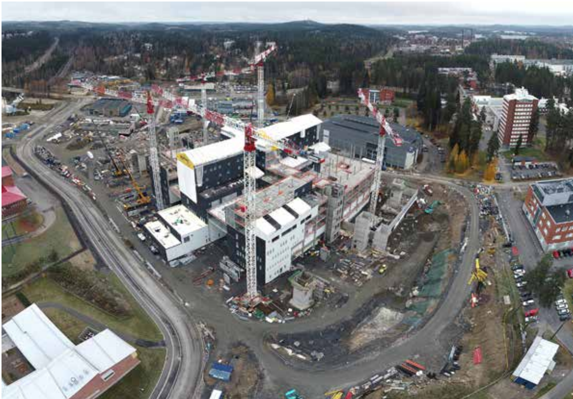
Ilmakuva työmaalta viime syksynä.
