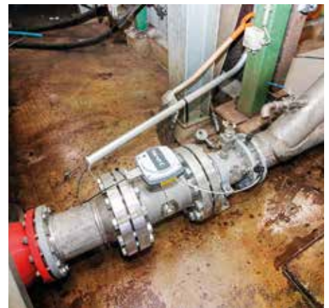
Mikroaloteknologiaan perustuva Valmet Total Solids Measurement (Valmet TS) -kokonaiskiintoainemittaus soveltuu jäteveden puhdistuksessa syntyvälle lietteelle (0-40% TS).
