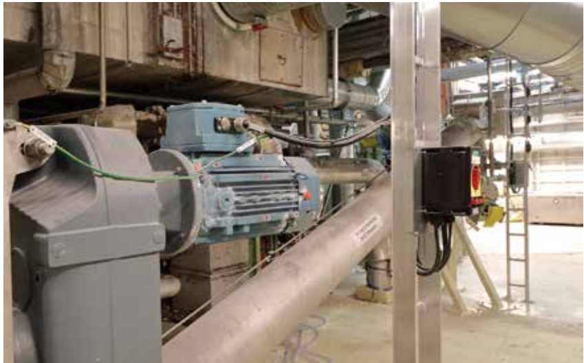
Kuvassa yksi viidestäkymmenestä sähkömoottorista, joita säädetään Profinetin ja Valmet DNA -automaatiojärjestelmän avulla.
