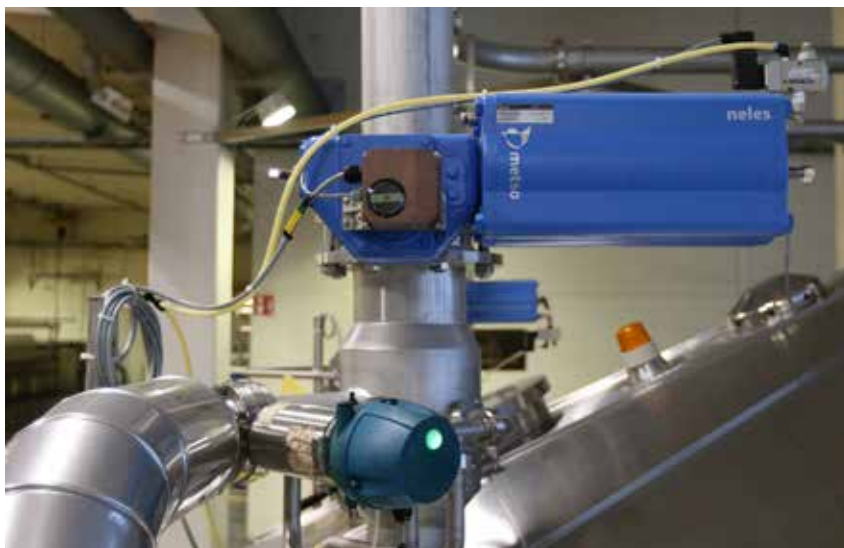
Oluen valmistusprosessissa on sadoittain venttiileitä ja niihin liittyviä toimilaitteita eri vuosikymmeniltä.
