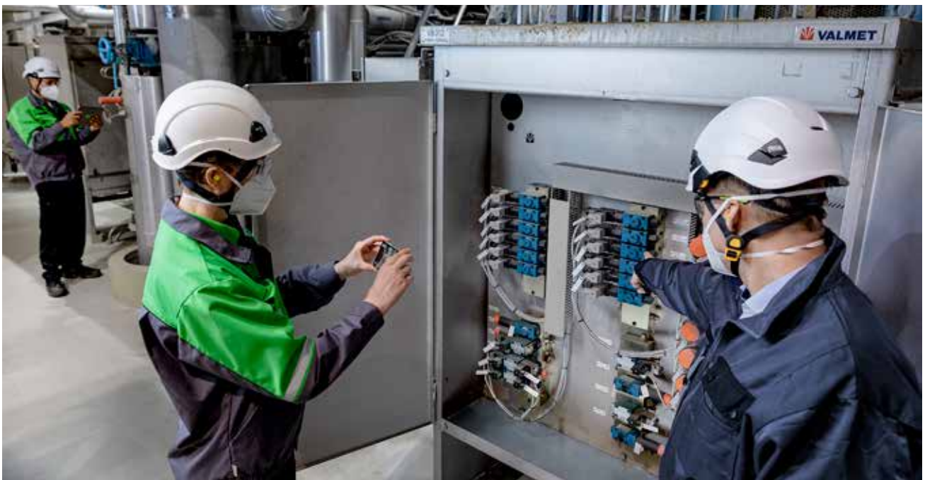
Kännykän kameraan ja näyttöön perustuva lisätty tieto (AR) mahdollistaa huoltotilanteissa asiantuntijoiden neuvojen esittämisen paikalliselle huoltomiehelle, samalla kun kamerakuvaa striimataan verkon yli.
