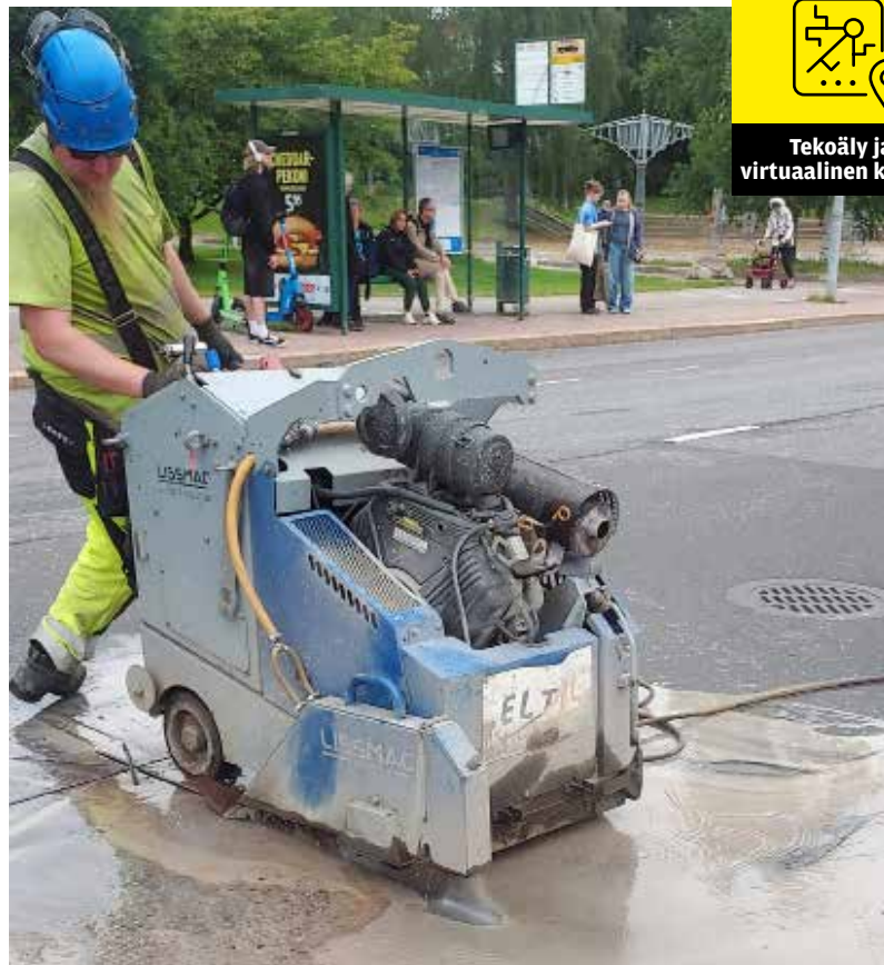
Asfalttia sahataan Helsingissä. Mikrokuituputkisto taipuu hyvin silmukoiksi älykkääseen tieinfraan kuljettamaan dataa.
